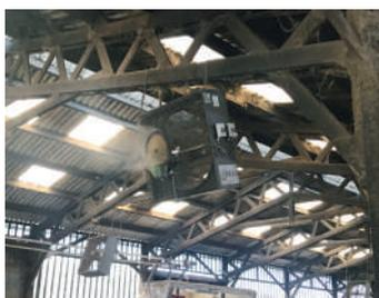
La brumisation fonctionne en couplage avec les ventilateurs verticaux à flux horizontal. Son principal handicap est d'ajouter de l'humidité dans le bâtiment. Un autre handicap est son entretien, notamment dans les zones où l'eau est calcaire, les orifices se bouchant facilement. Bien positionnée, bien entretenue, la brumisation est un élément de confort supplémentaire.
